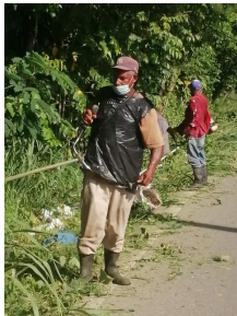
Limpieza de escombros en calle principal Primavera
